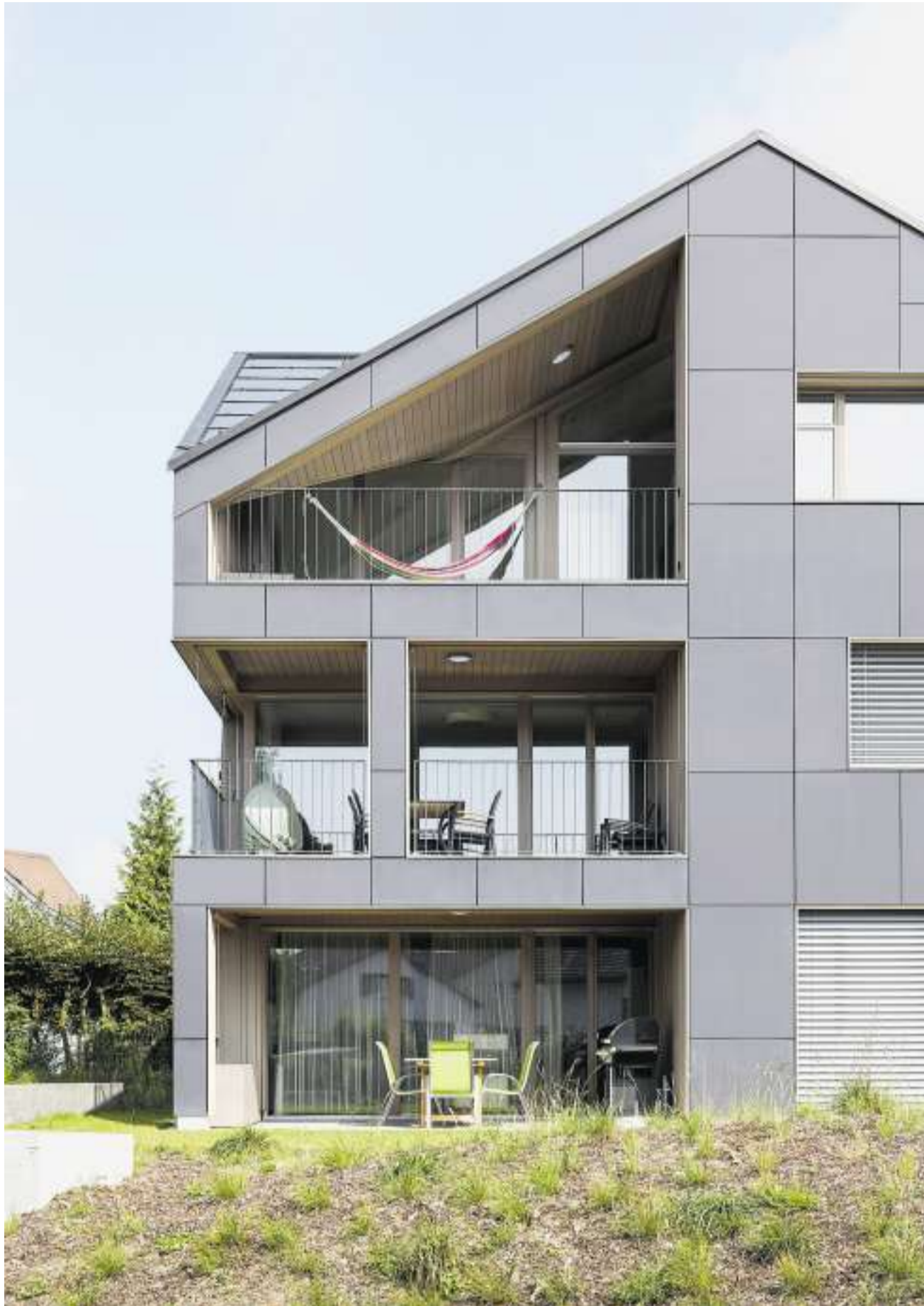
Der Fassade des neuen Mehrfamilienhauses in Brütten sieht man nicht an, dass sie aus Solarpaneelen besteht.
